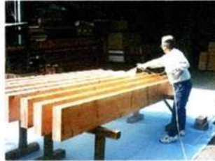
防火処理加工中
