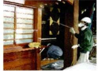
防火処理加工中
