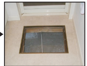
床下侵入方法 ◎床下収納庫を引き抜いて侵入してください
